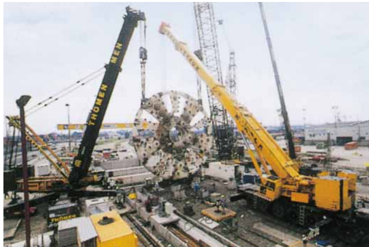
Montage der Schildvortriebsmaschine – Einheben des Schneidrades in den Startschacht
