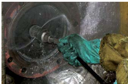
Hydrodynamische Reinigung der Leitung eines Ölsystems
