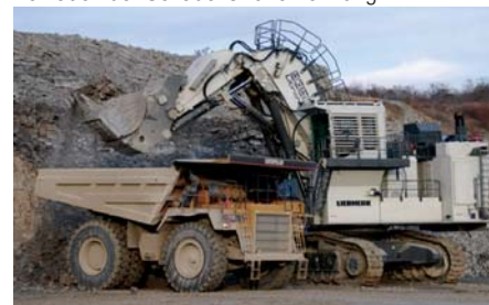
Reißen von Kalkgestein & Verladen auf Dumper
