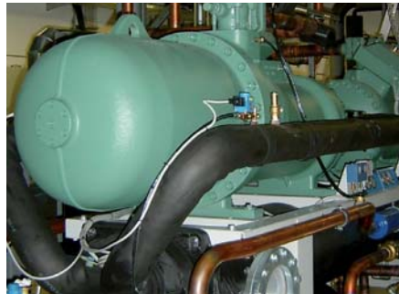
CLIMAVENETA-Schraubenverdichteranlage zur Prozesskühlung und Klimatisierung von Gebäuden
