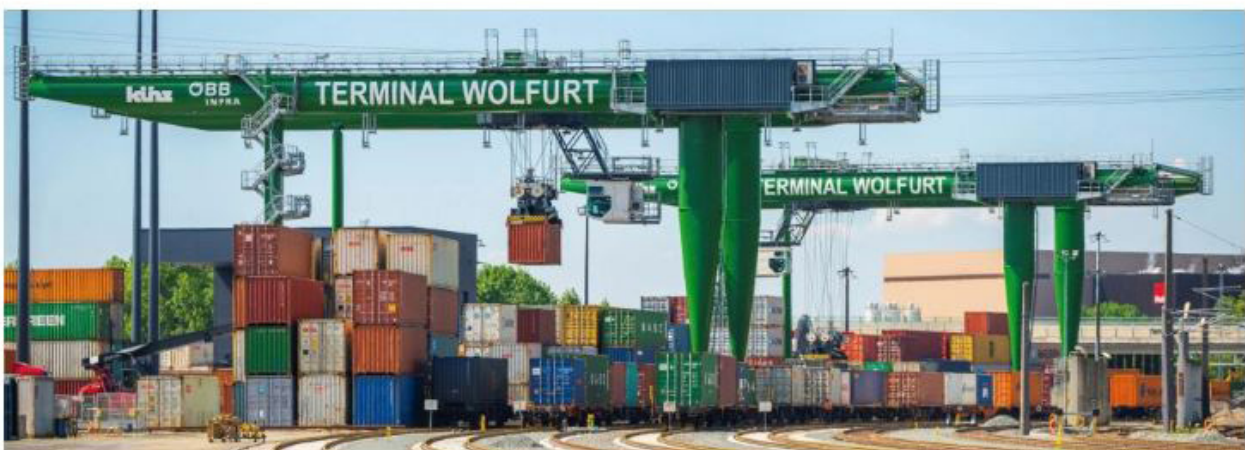
Künz Containerkrane sorgen im ÖBB Cargozentrum Wolfurt für höhere Verladekapazitäten. - Bild: Künz
