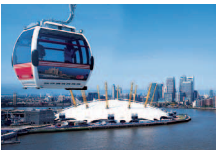
Die „Emirates Air Line“ in London
