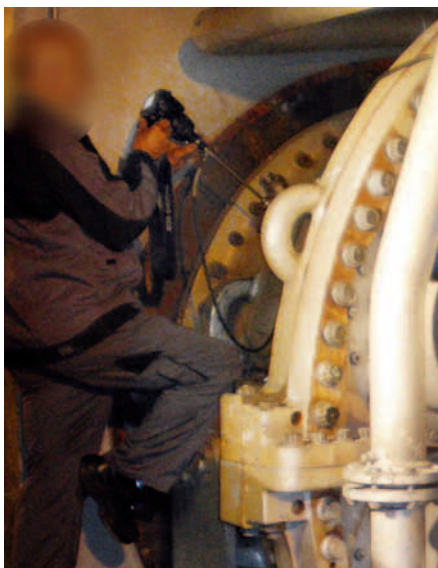
Gasturbine wird mit Boroskop (Endoskop) auf Schäden untersucht
