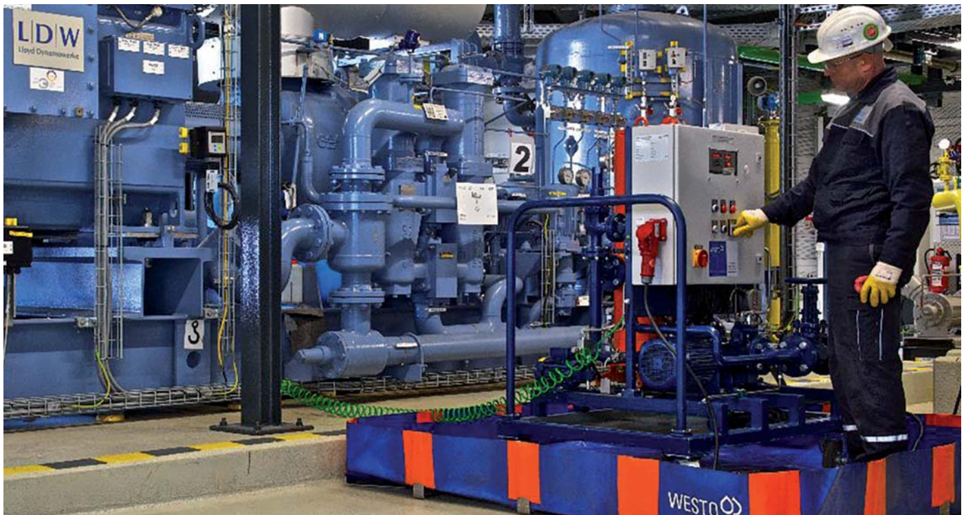
Von WESTO und Currenta gemeinsam entwickelt: ein speziell für die Schraubenverdichter der Kälteerzeugung konzipiertes Nebenstromfilteraggregat, das den Ammoniak-Anteil (NH 3 ) im Ölkreislauf berücksichtigt.
